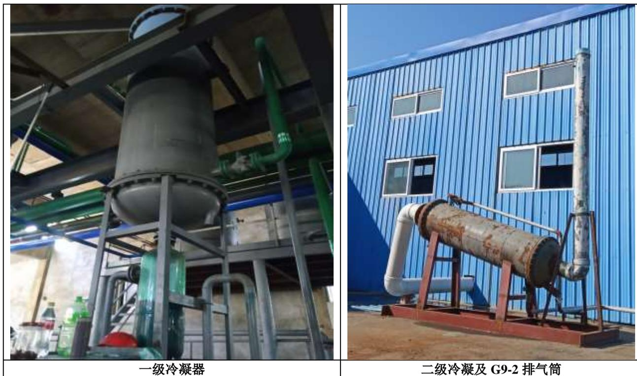
图 4.1-7 蒸馏工艺废气处理现场图
