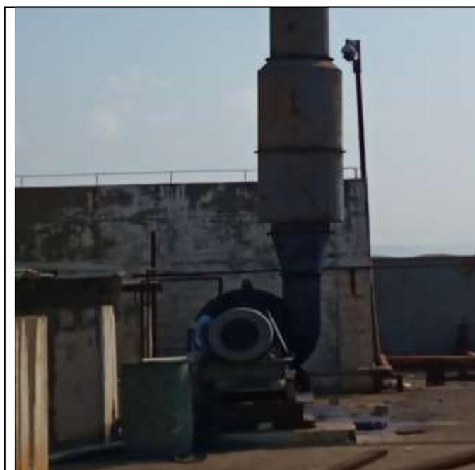
风机出口设置消声器，风机基础为减振基础
