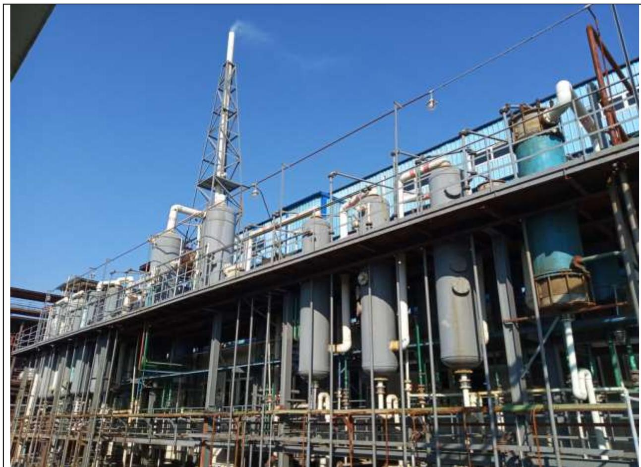
图 4.1-5 酞菁绿车间废气喷淋吸收处理系统现场图
