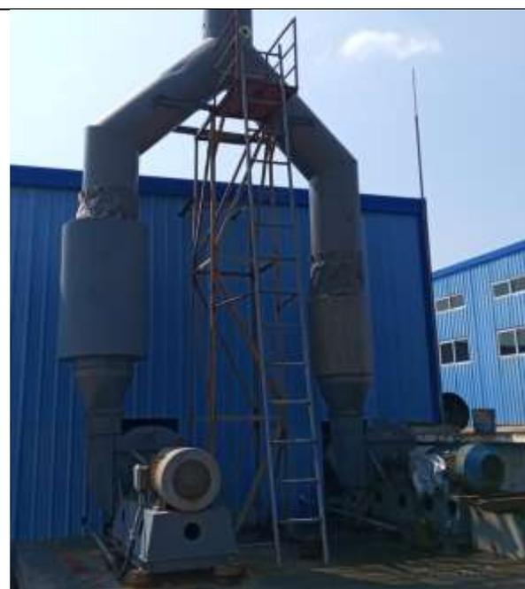
风机出口设置消声器，风机基础为减振基础
